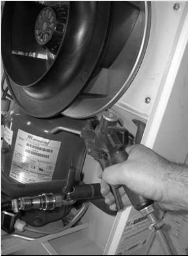
Imagen 56: Aplicar aire a presión en el registro del intercambiador de calor y el espacio del compresor (2)
