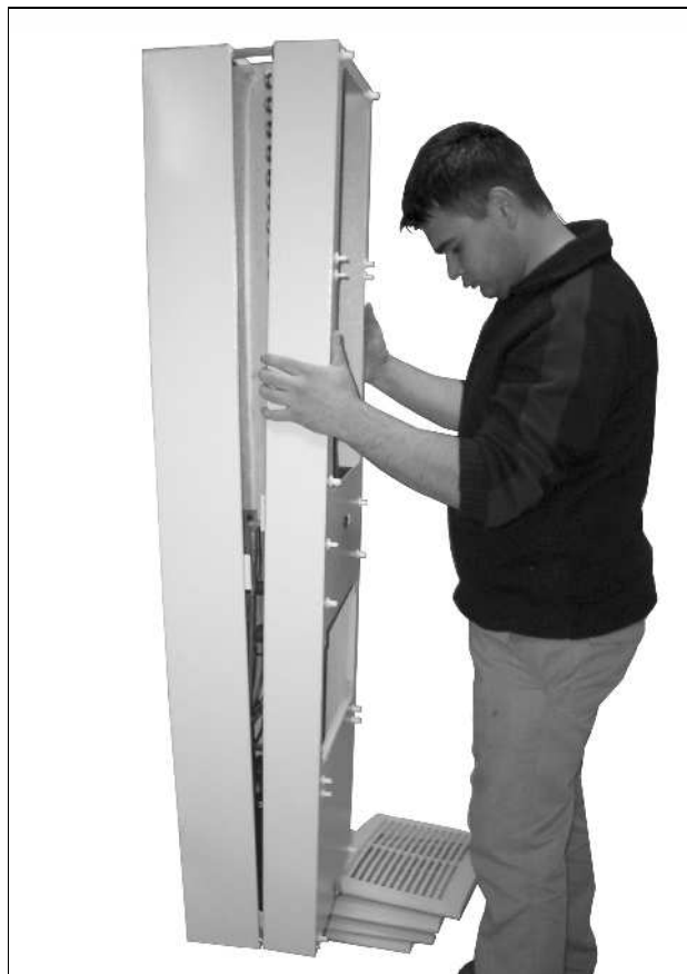
Imagen 75: Desmontaje de la cubierta
