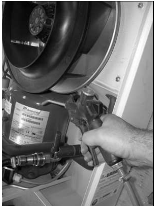
Imagen 80: Aplicar aire a presión en el registro del intercambiador de calor y el espacio del compresor (3)
