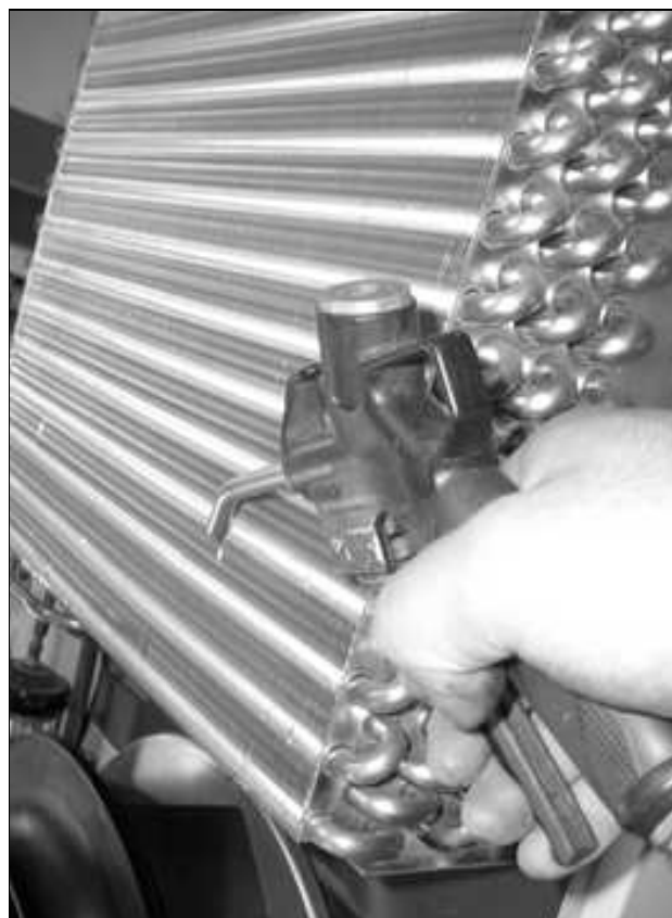
Imagen 55: Aplicar aire a presión en el registro del intercambiador de calor y el espacio del compresor (1)
